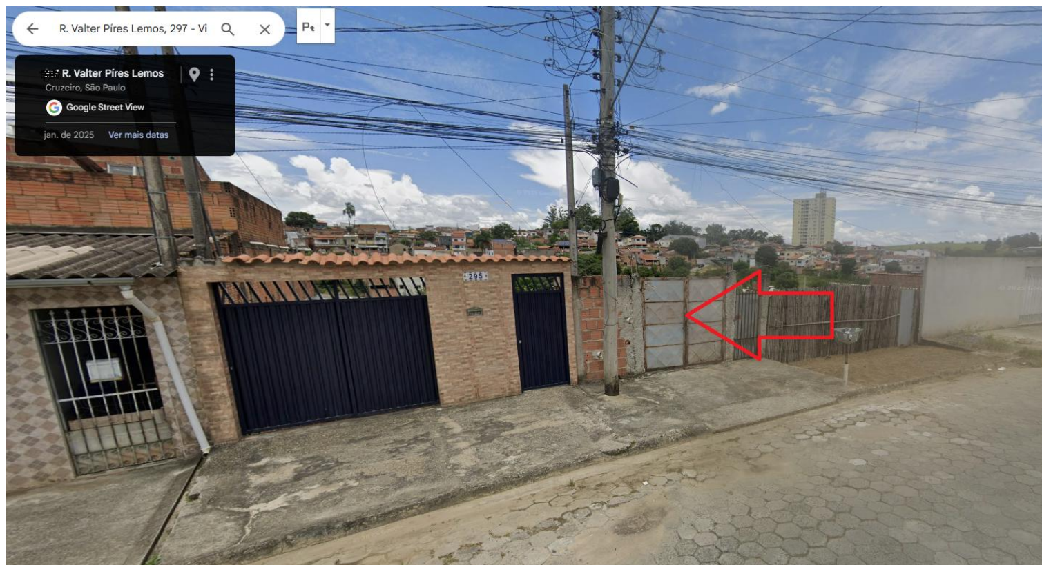
Base do poste
