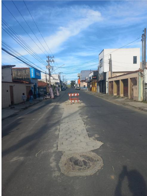
**Justificativa:** Verificar os motivos pelos quais a autarquia SAAE não está cumprindo legislação vigente, conforme evidenciado na foto em anexo, onde simplesmente causa danos na estrutura asfáltica viária e depois não recompõe o asfalto nas condições originais.
